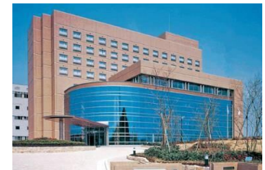
研修施設 テクノセンター（兵庫県三田市）
